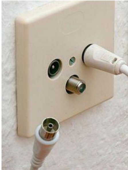
FBAS Stecker und Buchse für Antennensignal
