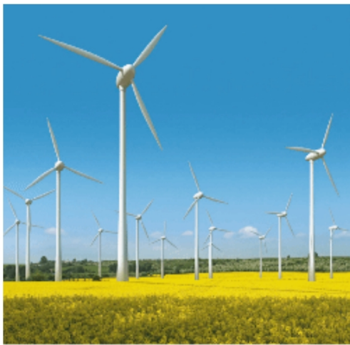
68.1 Windpark im Burgenland: Auf Türmen von 85–100 m Höhe treiben Rotorblätter von bis zu 40 m Länge Generatoren zur Stromerzeugung an. 1119 Windenergieanlagen standen im Jahr 2015 in Österreich in Betrieb.
