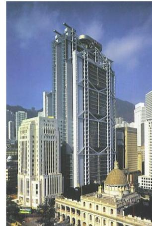
Form: Der Architekt Foster entwarf einen Bau, bei der die Tragekonstruktion nach außen demonstrativ zur Schau gestellt wird. Acht Masten aus jeweils vier Röhren tragen das Gebäude. Treppen, Lifte und Sanitäreanlagen liegen außen.
